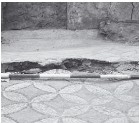
Abb. 91: Raum 38d, Mosaikboden mit Erdbebenriss
