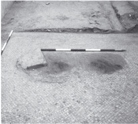
Abb. 70: Raum 38a, Mosaikboden mit Brandspuren
